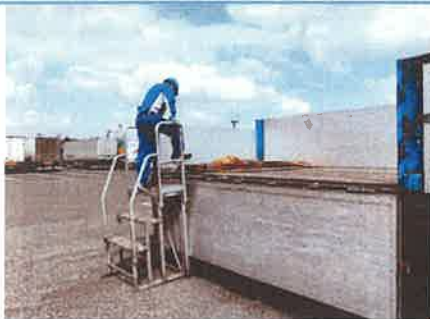
墜落・転落防止：昇降台の導入
